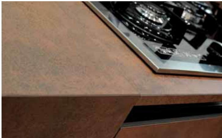
45° Mitered edge / Bord à onglet de 45°
